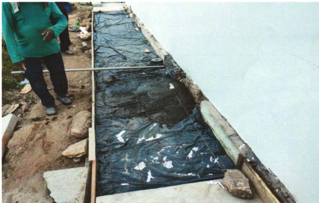
FOTO 35 – EXECUÇÃO DE PASSEIO (CALÇADA) OU PISO DE CONCRETO COM CONCRETO MOLDADO IN LOCO, FEITO EM OBRA, ACABAMENTO CONVENCIONAL, ESPESSURA 8CM, ARMADO. AF_072016
