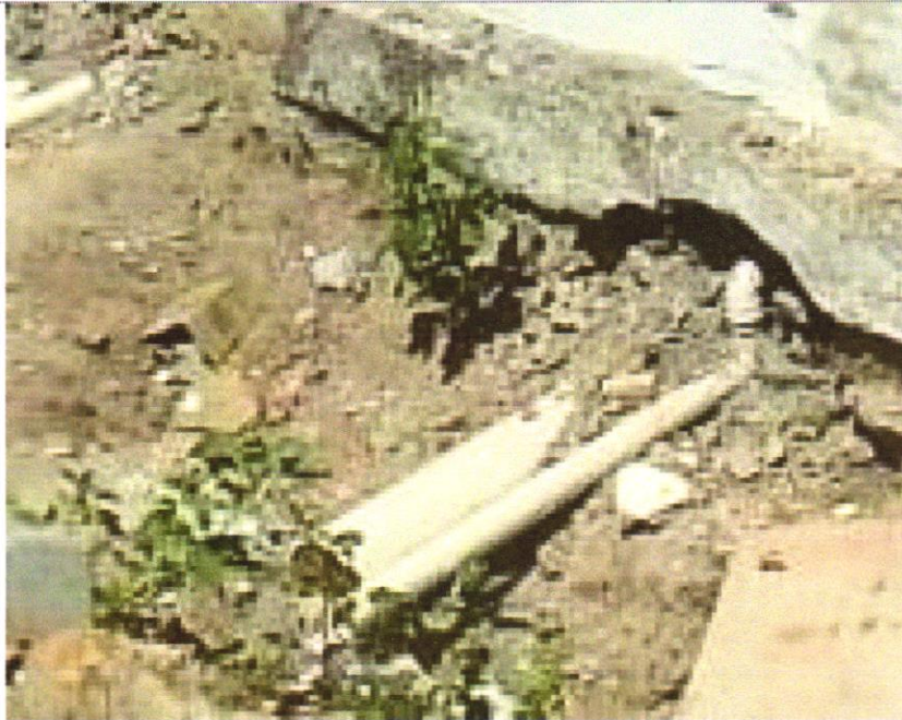
FOTO 41- TUBO DE PVC BRANCO PARA REDE COLETORES DE ESGOTO CONDOMINIAL DE PAREDE MACIÇA, DN 100 MM, JUNTA ELÁSTICA - FORNECIMENTO E ASSENTAMENTO. AF_01/2021
