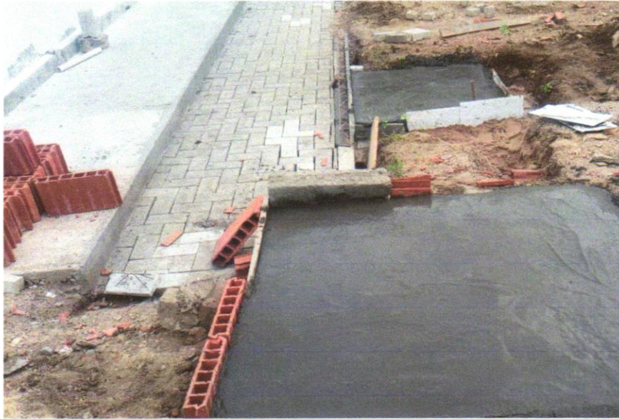
FOTO 25 - Sumidouro paredes com blocos cerâmicos 6 furos e dimensões internas de 1,75 x 1,00 x 1,00 m
