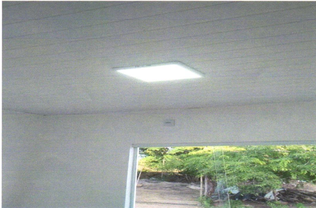
FOTO 23 - Luminária sobrepor quadrada Led 24W*, 6500K G- Light ou similar
