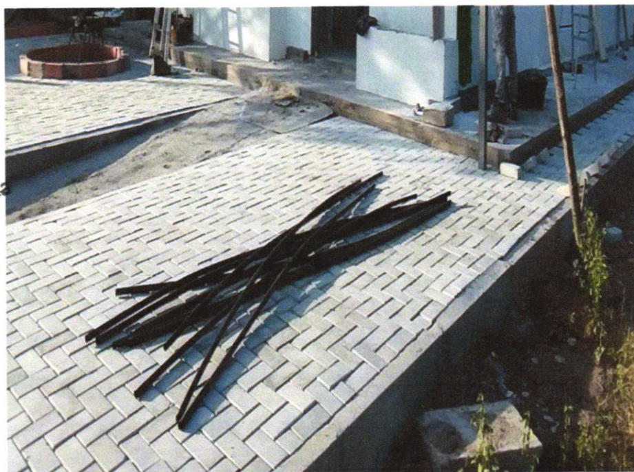
FOTO 04-EXECUÇÃO DE PASSEIO EM PISOINTERTRAVADO
