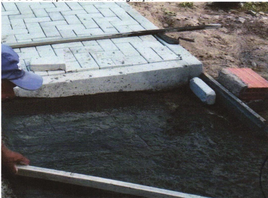
FOTO 34 – PISO EM CONCRETO 20 MPA PREPARO MECÂNICO, ESPESSURA 7CM. AF_09/2020
