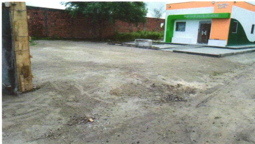
FOTO 17 – EXECUÇÃO E COMPACTAÇÃO DE BASE E OU SUB BASE PARA PAVIMENTAÇÃO DE BRITA GRADUADA SIMPLES - EXCLUSIVE CARGA E TRANSPORTE. AF_11/2019
