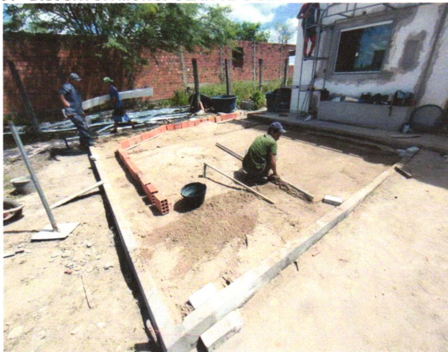
FOTO 32 – Assentamento de Guia meio Fio
