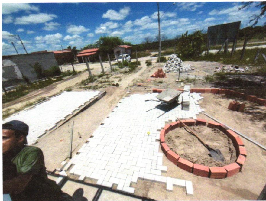
FOTO 06-EXECUÇÃO DE PASSEIO EM PISOINTERTRAVADO
