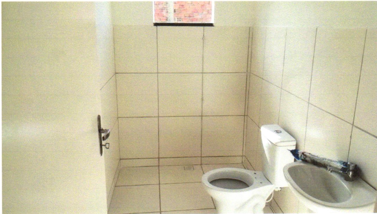
FOTO 13 – REVESTIMENTO CERÂMICO PARA PISO COM PLACAS TIPO ESMALTADA EXTRA DE DIMENSÕES 45X45 CM APLICADA EM AMBIENTES DE ÁREA MAIOR QUE 10 M2. AF_06/2014
