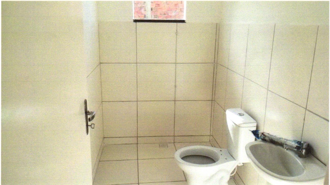
FOTO 15 – REVESTIMENTO CERÂMICO PARA PISO COM PLACAS TIPO ESMALTADA EXTRA DE DIMENSÕES 45X45 CM APLICADA EM AMBIENTES DE ÁREA MAIOR QUE 10 M2. AF_06/2014
